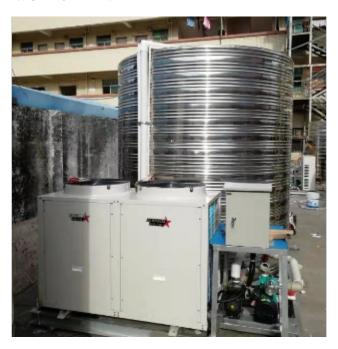
分体式空气能热水器包括主机和承压保温水箱,主机与水箱分开,运输、安装较为方便,分体机优点是蒸发器面积较大,能效比高,水箱100-500L可按需求搭配,比较灵活。一般配值为200升以下配960瓦的主机,250~300升配1250瓦的主机。此外,一体机和分体机都具备如节能,环保,安全,操作简单,全天候运行,智能控制,使用寿命长等优点,大家可以根据需要购买不同类型的空气能热水器。落地式安装,安装时只需要连接好进、出水管和排水管就可以投入使用了。外形更美观,没有类似空调外机的主机。广东学校空气能一体机热水器公司空气能热水器相对性电热水器和燃气热水器来讲更安全。
