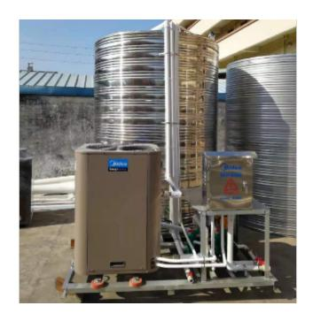
无论是安装在室内或室外,更不论阴天晴天,温度在零摄氏度以上,都可以使用。此外,用完一箱水后,空气能热水器只需要不超过一小时的时间便可以再制造一箱热水,可供一家人全天候使用。电热热水器存在漏电的安全隐患,燃气热水器存在煤气中毒的忧患,和这两种热水器相比,空气能热水器通过介质换热,避免了电加热元件和水直接接触,这样一来就解决了电热水器存在的漏电隐患,其次,因为原料是空气,因此也排除了燃气热水器煤气爆破或者煤气中毒的可能性,让人们使用得更加舒适无忧。
