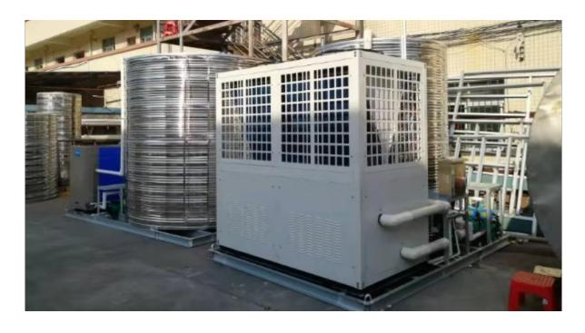
空气能热水器,也称"空气源热泵热水器"。"空气能热水器"把空气中的低温热量吸收进来,经过氟介质气化,然后通过压缩机压缩后增压升温,再通过换热器转化给水加热,压缩后的高温热能以此来加热水温。
